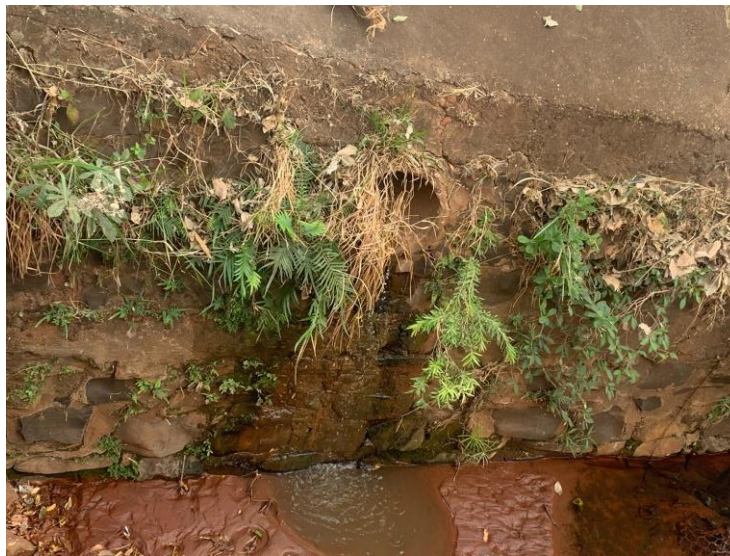
Figura 4: Esgoto clandestino sendo despejado no córrego Vertente Grande
